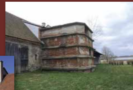
Severní stáj před rekonstrukcí, pohled z hospodářského dvora — pohled zezadu — těžká mechanizace během rekonstrukce (foto J. Mrázek, 2012) — hospodářský dvůr po obnově — zrekonstruovaná severní stáj (foto K. K. Brzák – Theresiae RTM, 2015).
