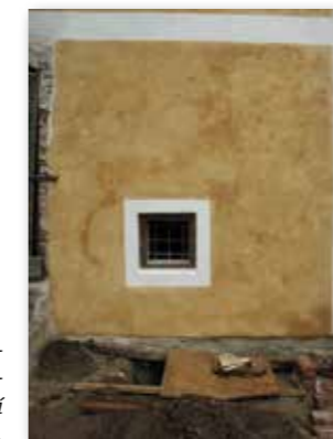
Detail nátěru omítky s přirozenou barevnou živostí, odpovídající nestejnorožnému složení historického zdiva, 2013.
