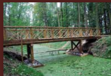
Poustevníkův mostek se zábradlím z větvoví – silných prutů tvrdých dřevin z náletových porostů.
