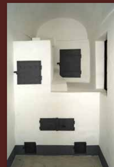
Zděné otopné zařízení v konci chodby v přízemí budovy severozápadního křídla, opravené s přísným respektováním původního stavu.
