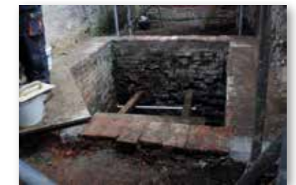
Oprava šachty pro hodinová závaží.
