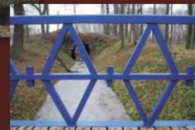
Mostek u Egyptského pavilonu má složitý tvar s vrcholovou plošinou, zde bylo nutno použít jako základ ocelovou konstrukci. Vpravo důsledně dodrženy předpokládaný původní detail u zábradlí.
