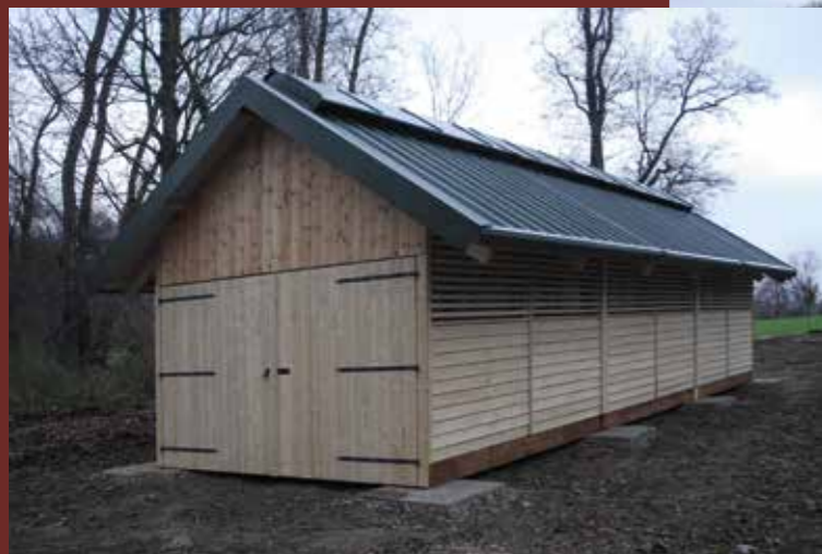
Nová dřevěná stavba ovčína — pohled na ovčín přes louku (foto J. Mrázek, 2012).
