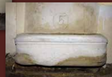
Původní kamenný žlab v konírně – jeden z nejvíce narušených, zde ve stavu po základní konzervaci dochovaného torza. Stejný žlab po doplnění chybějící části a celkovém tvarovém sjednocení.
