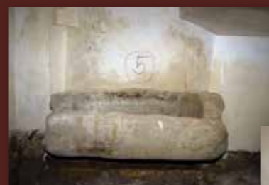
Původní kamenný žlab v konírně – jeden z nejvíce narušených, zde ve stavu po základní konzervaci dochovaného torza. Stejný žlab po doplnění chybějící části a celkovém tvarovém sjednocení.
