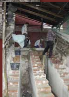
Hlavní zámecké schodiště před rekonstrukcí — vybourané schodiškové stupně — dělníci během rekonstrukčních prací (foto J. Mrázek, 2012) — a levá část schodiště po obnově (foto K. K. Brzák – Theresiae RTM, 2015).
