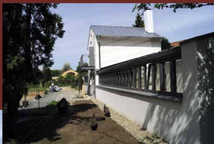
Zrekonstruovaná budova dolního skleníku s pařeništi a upraveným okolím (foto K. K. Brzák – Theresiae RTM, 2015).
