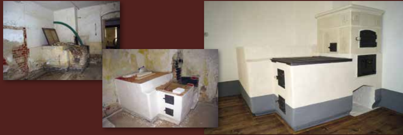
Bývalá cukrárna s vestavěnou pecí a podestou zděného sporáku. Vpravo – kachlová kobka s troubami je v této chvíli již demontována. Uprostřed – opravená pec a zděný sporák s litinovou plotnou, připravený na zpětné sestavení původní kachlové kobky po restaurování a doplnění jednotlivých dílů; vpravo – dokončená oprava sporáku s pecí v opraveném interiéru zámecké cukrárny.
