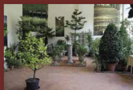
Oranžérie v lednu 2012 (foto J. Mrázek) — během rekonstrukce (foto T. Proněk, 2013) — po obnově, interiér (foto V. Láška, 2014).
